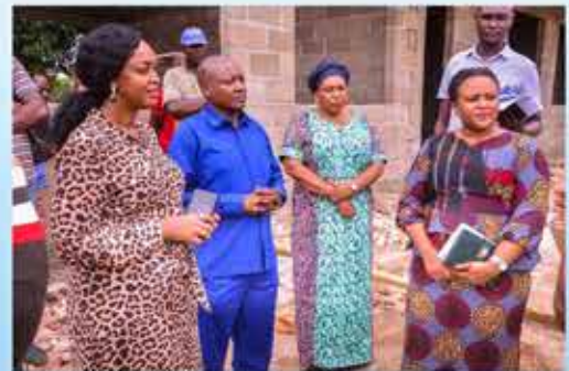
Mkurugenzi wa Halmashauri ya Jiji la Dar es Salaam, Ndugu Jumanne K. Shauri alipofanya ukaguzi kuangalia ujenzi wa vyumba vya madarasa Shule ya Sekondari Kinyerezi Annex sambamba na Mbunge wa Jimbo la Segerea Mhe. Bonnah Kamoli
